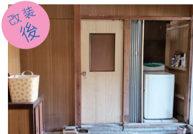
雑多な荷物を片付け、ドア横の壁を取り除いて空間を作り、洗濯機置き場を作っています。
