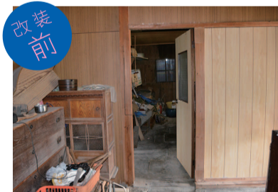
雑多な荷物を片付け、ドア横の壁を取り除いて空間を作り、洗濯機置き場を作っています。
