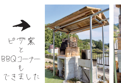
レンガのピザ窯とU字溝で作ったバーベキューのスペースは屋根付き！もちろんすべて手作りです！
